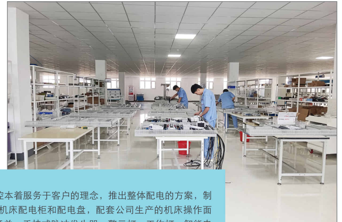
配电盘生产 组装现场
